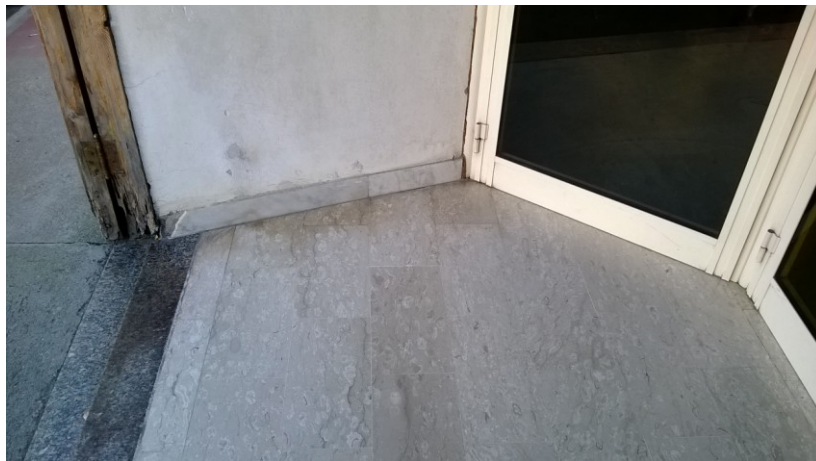
Dettaglio degli infissi di ingresso al piano terra
