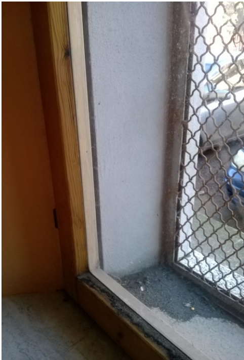
Infisso in legno del perimetro esterno e griglia di protezione
