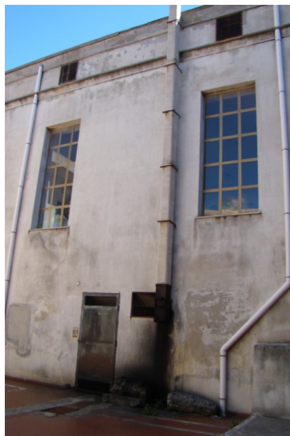
Residui di materiale misto ad eternit presente nel sottotetto e canna fumaria in eternit nel cortile
