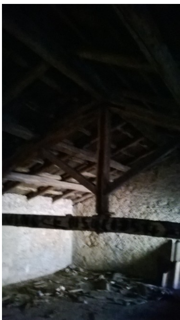
Residui di materiale misto ad eternit presente nel sottotetto e canna fumaria in eternit nel cortile
