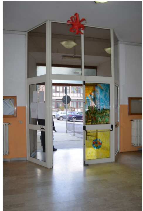
Infisso interno di ingresso
