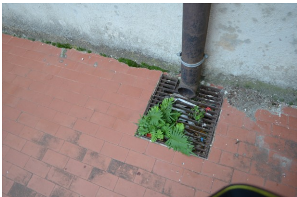
Caditoia nel cortile interno
